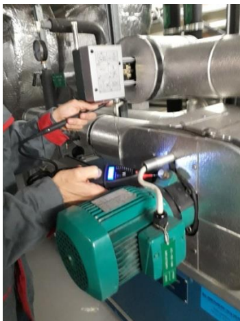
Vérification du conducteur de protection d'une installation de climatisation
